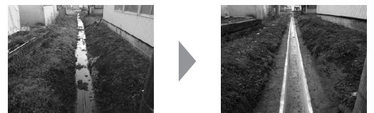
施工前 施工後
