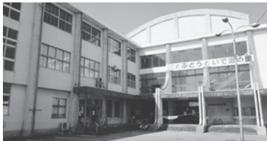
解体が待たれる旧市民会館
