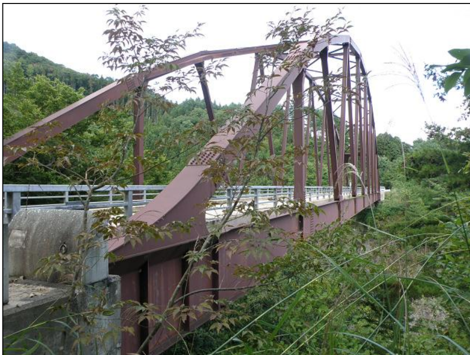
置賜東部線 置賜大橋（昭和61年架設）
