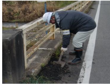
橋面の土砂撤去
