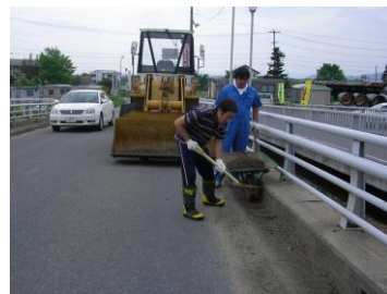
橋面の土砂撤去
