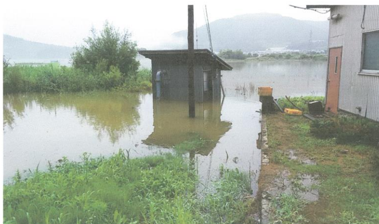
令和2年7月29日 早朝 南陽市川樋 山崎地内 3号ポンプ場付近
