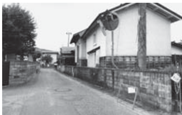
撤去前のブロック塀（結城記念館）
