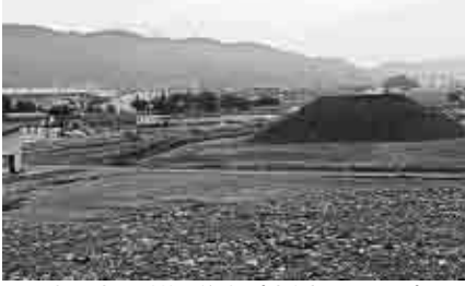
建設中の梨郷道路（東側をのぞむ）
