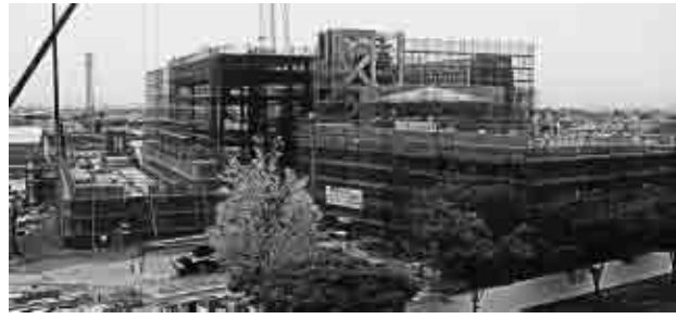
建設中の新文化会館
