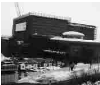
建設中の新文化会館
