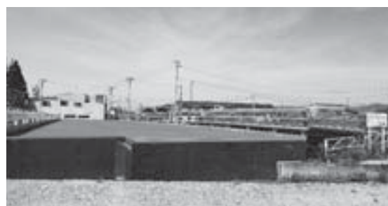
花見橋の仮橋
