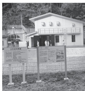
水窪ダム小水力発電施設
