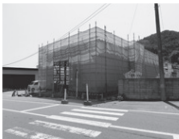
建設中の醸造施設
