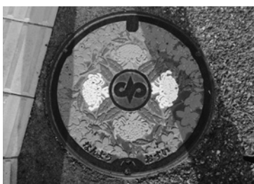
下水道マンホール
