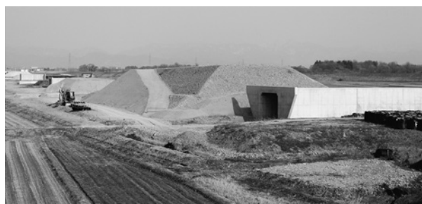
工事中の新潟山形南部連絡道
