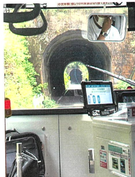
元は列車用トンネル
