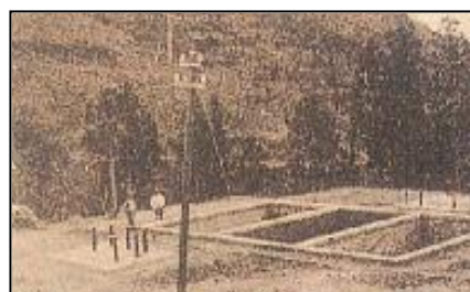
ろ過池(昭和9年)
