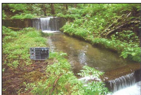
矢引沢取水口
