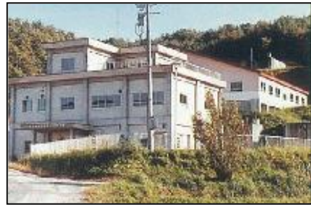
旧最上川浄水場
