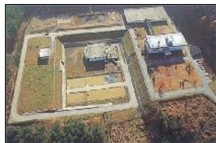
小滝浄水場膜ろ過施設
