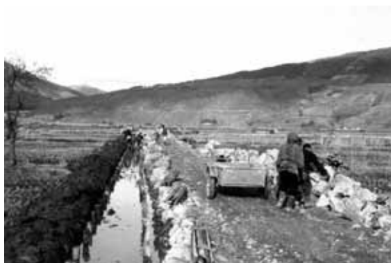
写真5 道路と水路の工事中的写真
