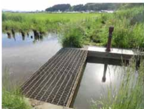
写真1 高水期 白竜湖排水水門への逆流 (第16図⑩)2017.6.6 左手が横堀排水路
