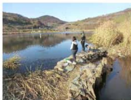
写真2 白竜湖南側の土嚢溢流堤 2017.11.3 低水期 手前は東側排水路(第16図⑨)
